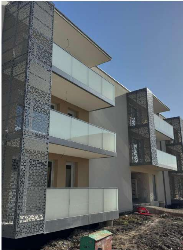
Quatre bâtiments de deux étages accueilleront 80 logements destinés aux seniors.
