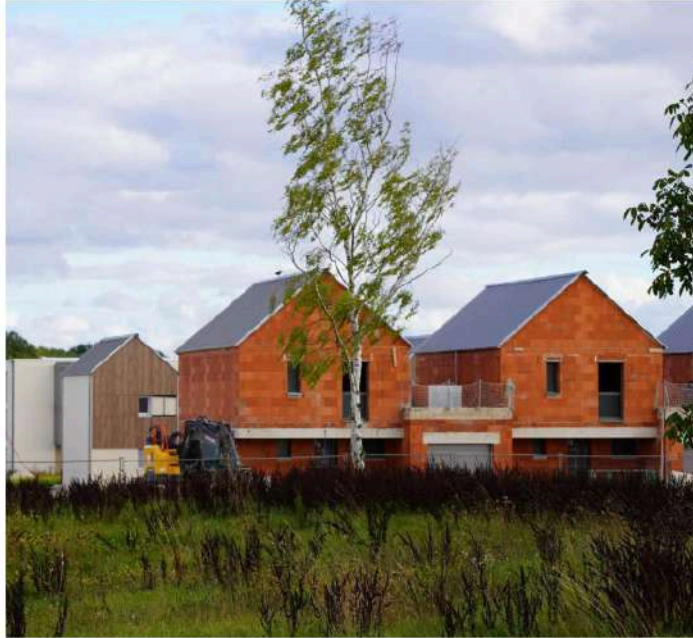
La viabilisation des terrains de l'éco-quartier du Moulinet concentre la majorité des investissements sur la période étudiée.
