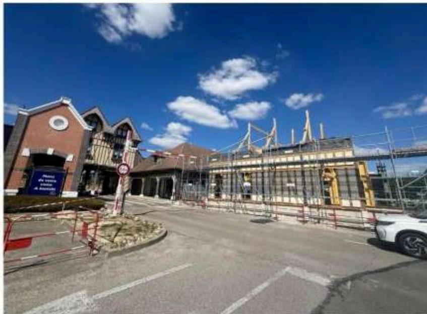
C'est à l'entrée du centre, face à l'enseigne Mango, dans un nouveau bâtiment encore en construction, que Paul Le Café va ouvrir.
