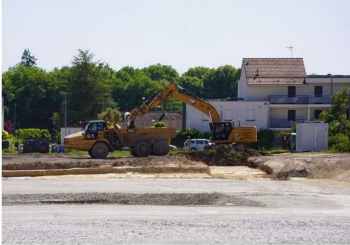
Les engins de chantier ont pris possession du terrain derrière le cinéma Utopia à Pont-Sainte-Marie depuis quelques semaines.
