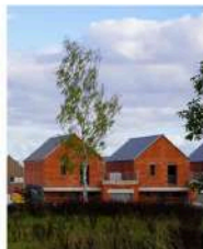
500 nouveaux logements, comme ici au quartier du Moulinet, ont vu le jour sur les dix dernières années selon Pascal Landréat. Archives
